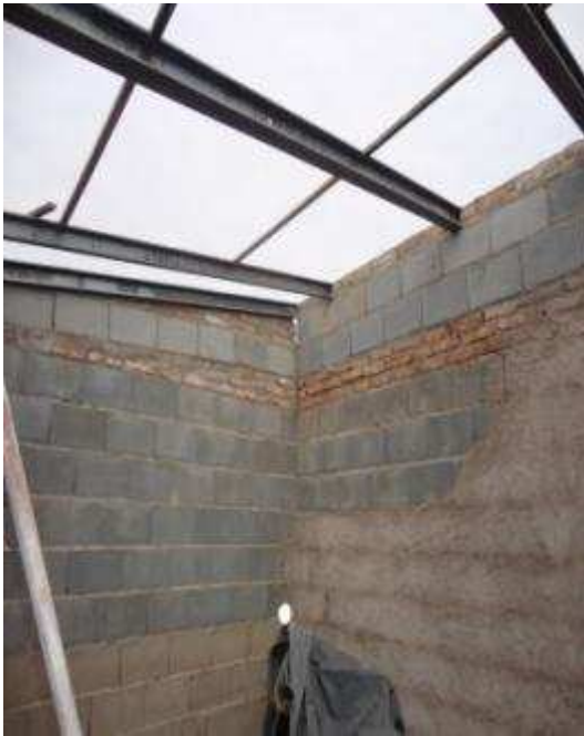
Sistema estructural modular de perfiles C – Anclaje con planchuelas a muros existentes
