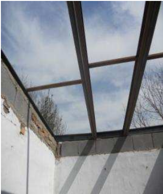
Estructura modular de perfiles C realizada in situ – cubierta de chapa galvanizada N° 25
