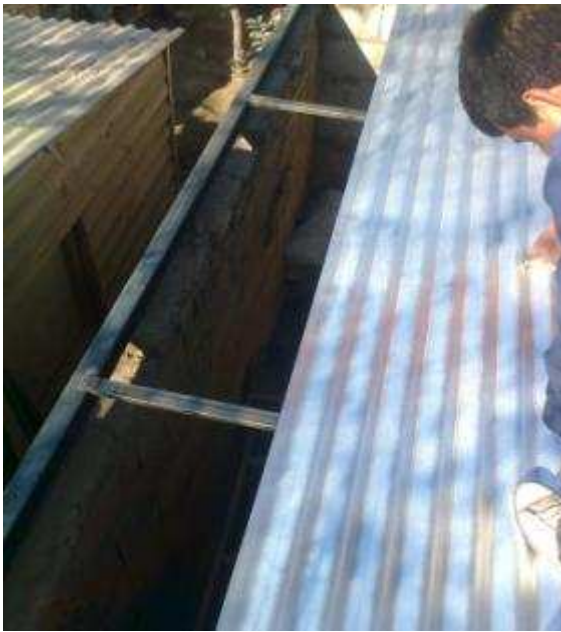
Estructura modular de perfiles C – Cubierta de chapa galvanizada
