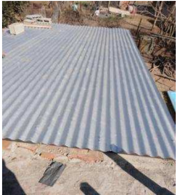
Estructura modular de perfiles C realizada in situ – cubierta de chapa galvanizada N° 25
