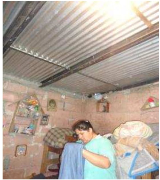
Estructura modular de perfiles C – Cubierta de chapa galvanizada
