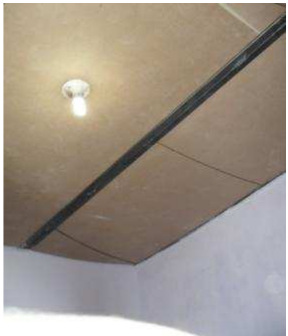
Sistema estructural de perfiles C – cielorraso de MDF suspendido sobre estructura
