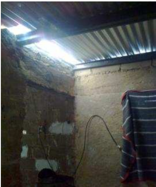
Montaje de chapas galvanizada sobre estructura – Estructura amurada con cubierta de chapa galvanizada
