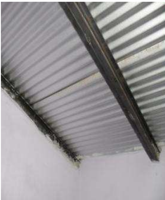
Sistema estructural de perfiles C – cielorraso de MDF suspendido sobre estructura
