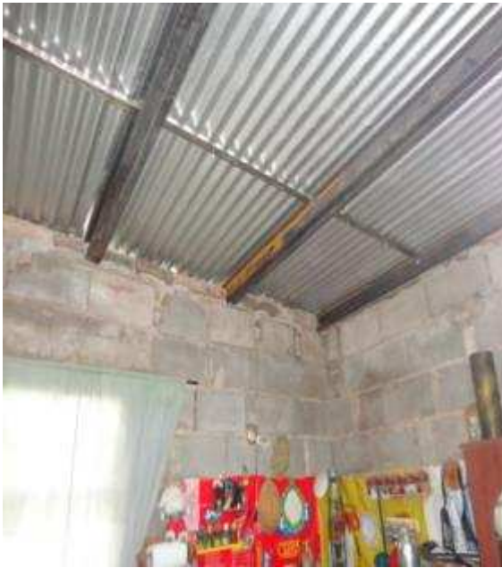
Sistema estructural modular de perfiles C construido in situ
