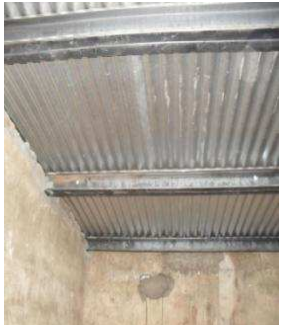
Montaje de chapas galvanizada sobre estructura – Estructura amurada con cubierta de chapa galvanizada
