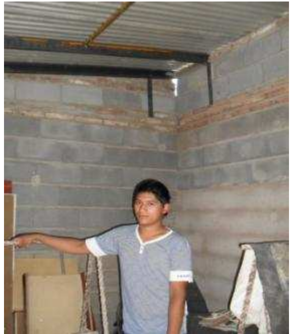
Sistema estructural modular de perfiles C – Anclaje con planchuelas a muros existentes
