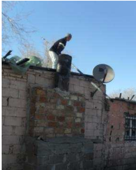
Construcción de cubierta de chapa galvanizada sobre estructura existente con cielorraso de madera
