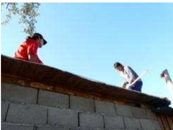
Construcción de cubierta de chapa galvanizada sobre estructura existente con cielorraso de madera
