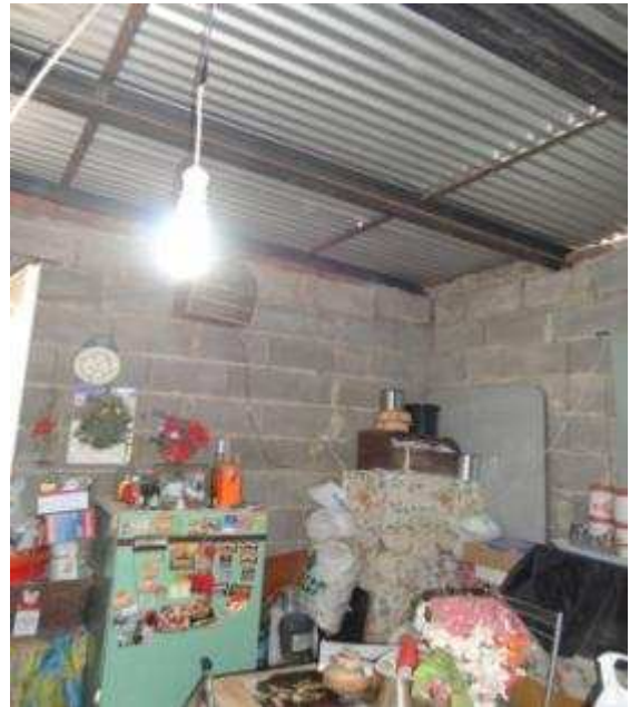
Sistema estructural modular de perfiles C construido in situ
