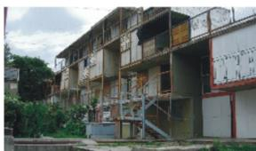
constaba de panelería prefabricada y ensamblada en seco, y el acabado en pintura con colores estridentes como el azul y el naranja ,estos colore se utilizaron para los aventanamientos, escaleras de circulación y barandas.
